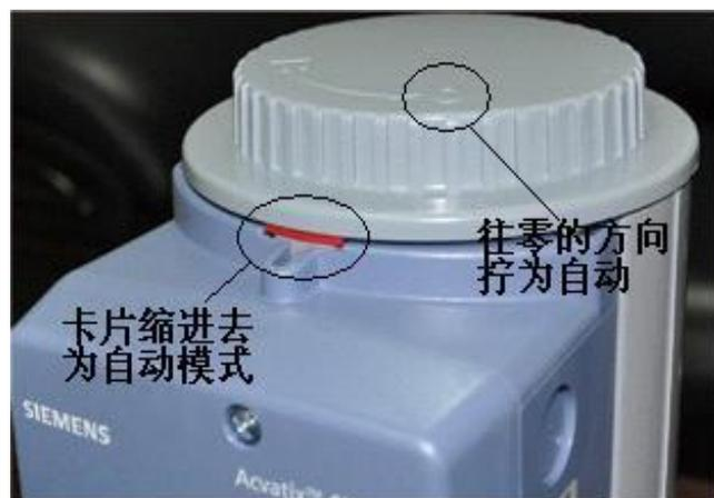
上方两图红色卡片露在外面, 表示执行器处于手动状态
